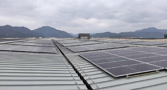
象山物流倉庫佈設光伏發電
